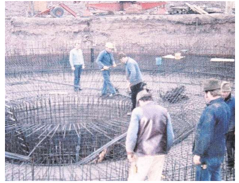
1978 baute die Gemeinde die Kläranlage bei Burgioß – Kosten: 2 Millionen Mark.
