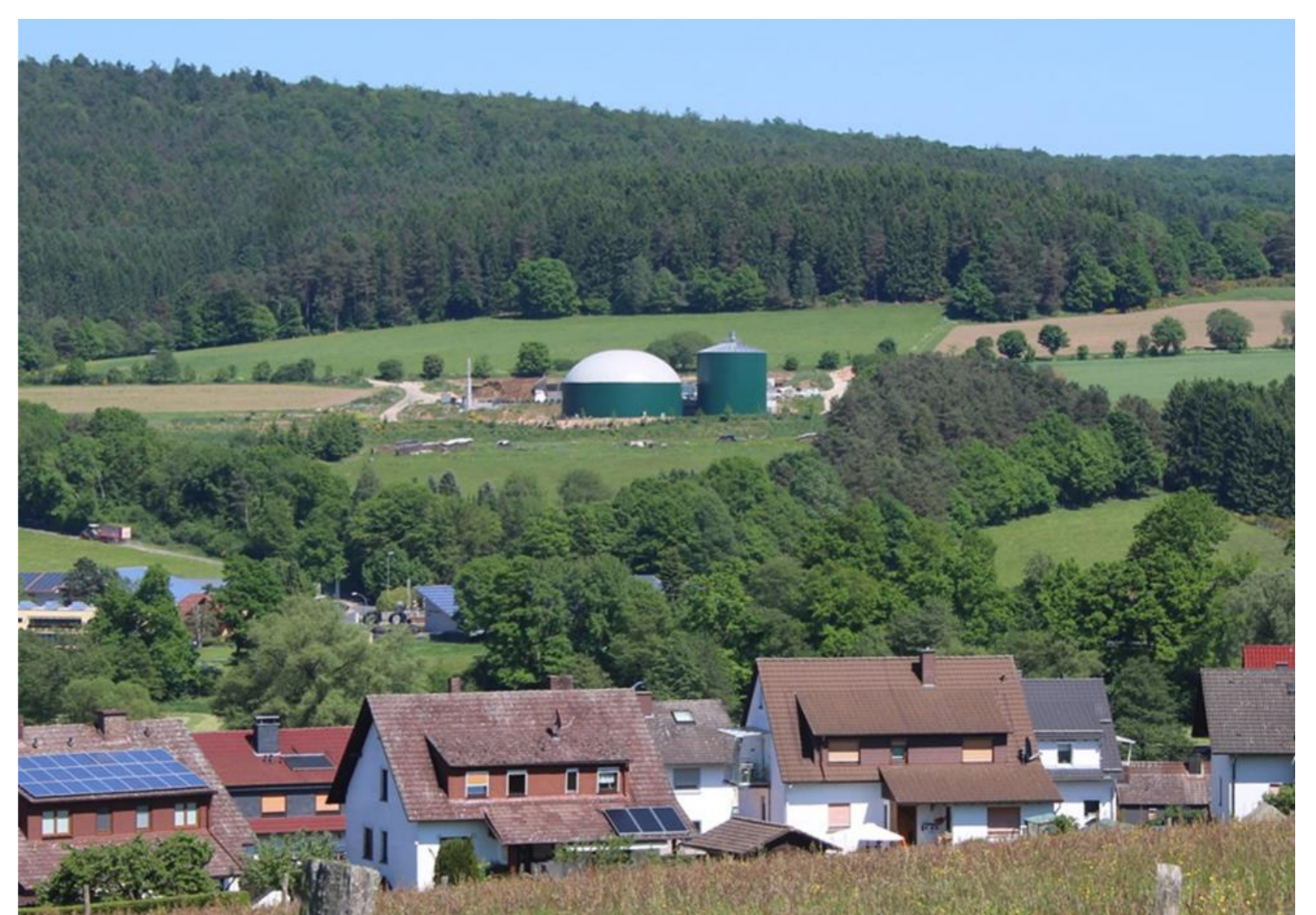
2014 Die Biogasanlage in Burgjoß geht in Betrieb. Sie erzeugt Strom und gibt die dabei gewonnene Wärme an das Heizungsnetz im Ort ab. ( Karl Damian )
