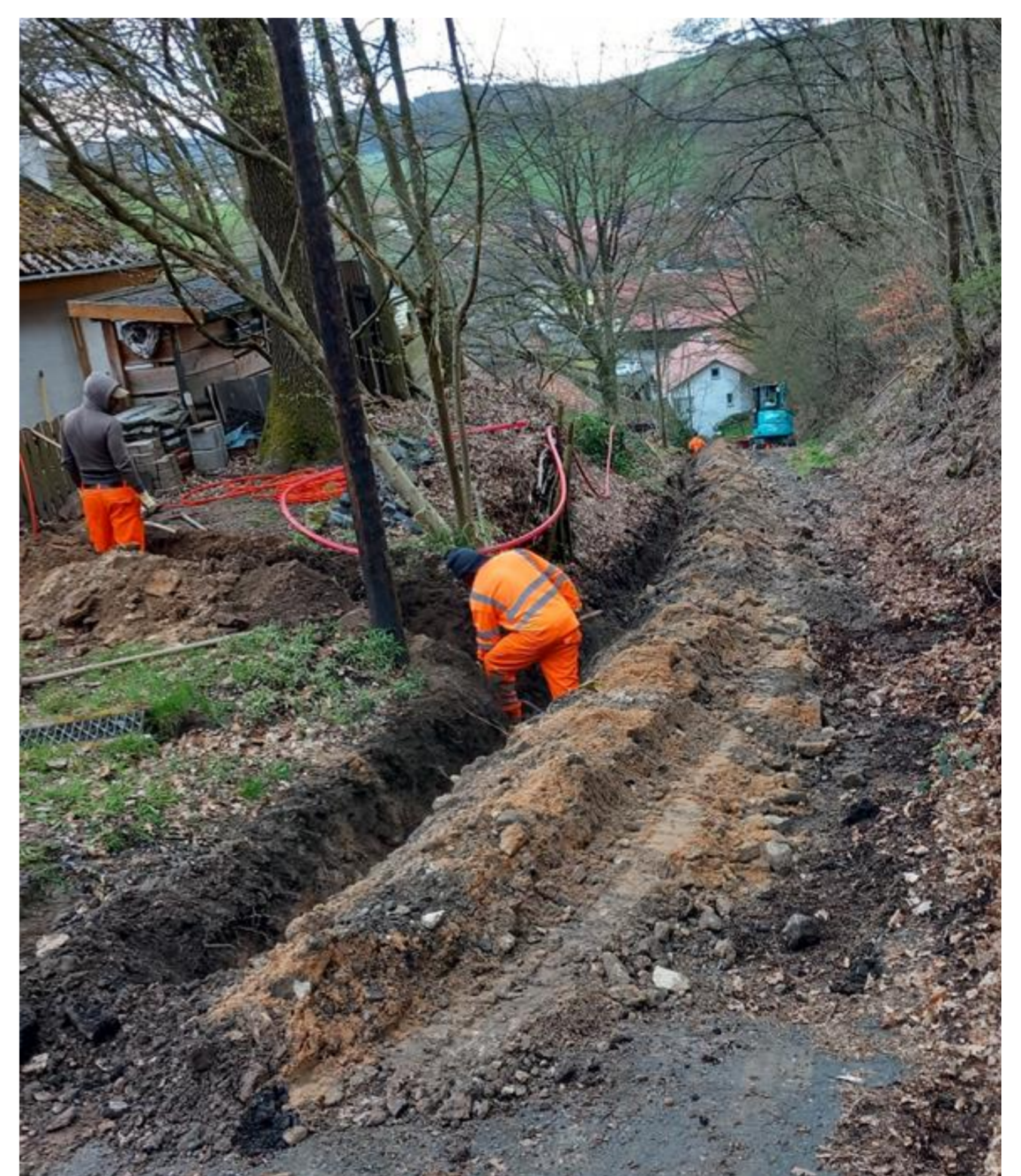
2023 In Pfaffenhausen beginnt die Verlegung der Glasfaseranschlüsse. ( Karl Damian )
