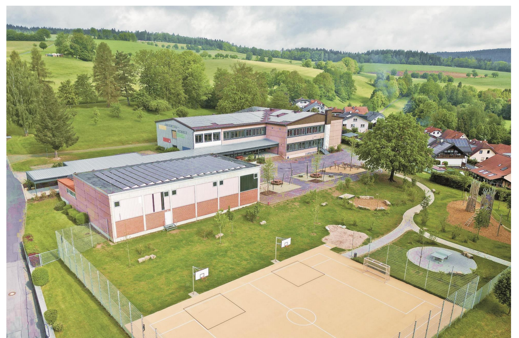
1972 Jossatal-Schule (zweizügige Grundschule), Bild von 2024. ( Christian Damian )
