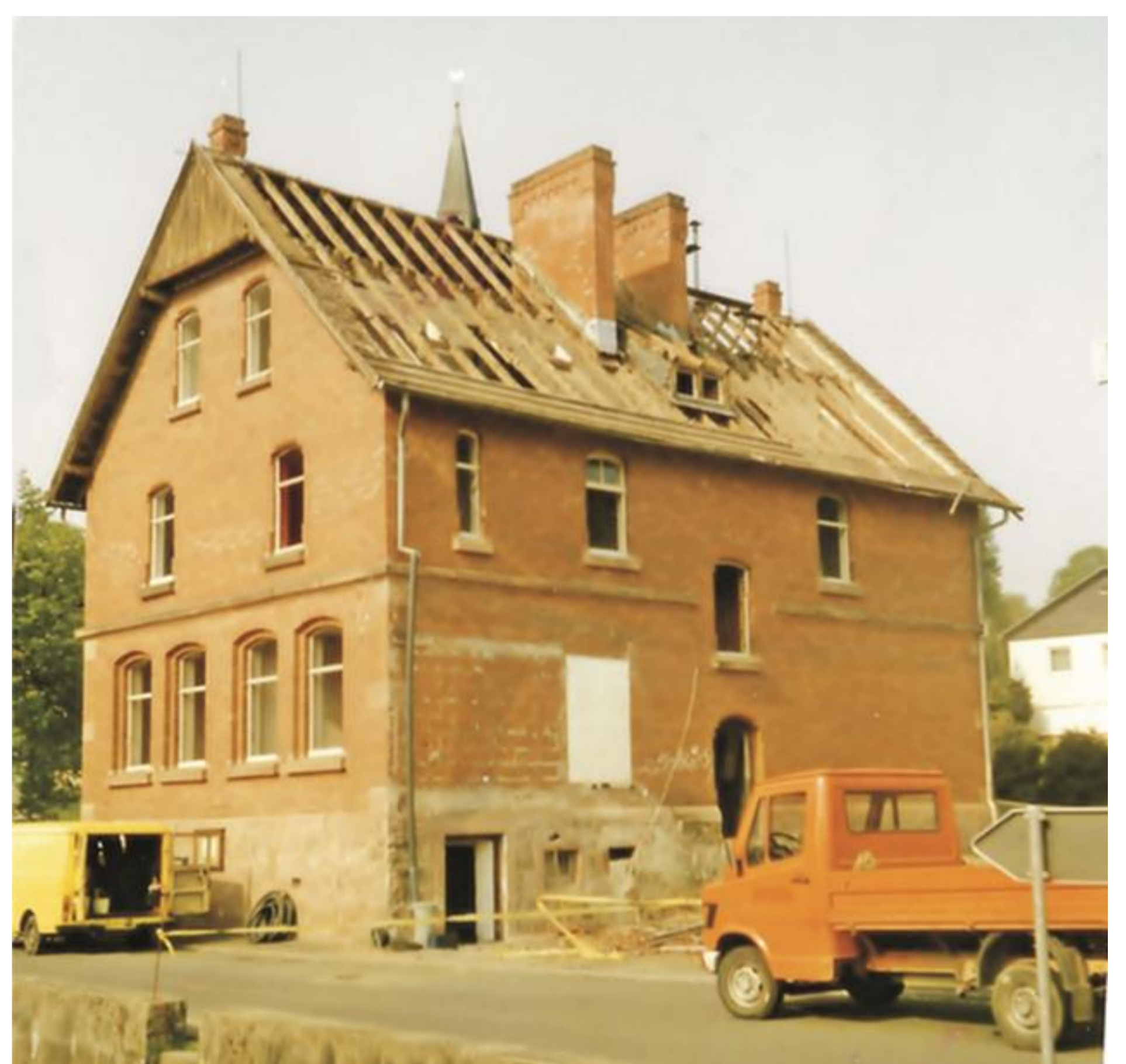
1988 Abriss der früheren Schule und des späteren Rathauses in Oberndorf für den Neubau des Bürgerhauses. ( Franz Korn )
