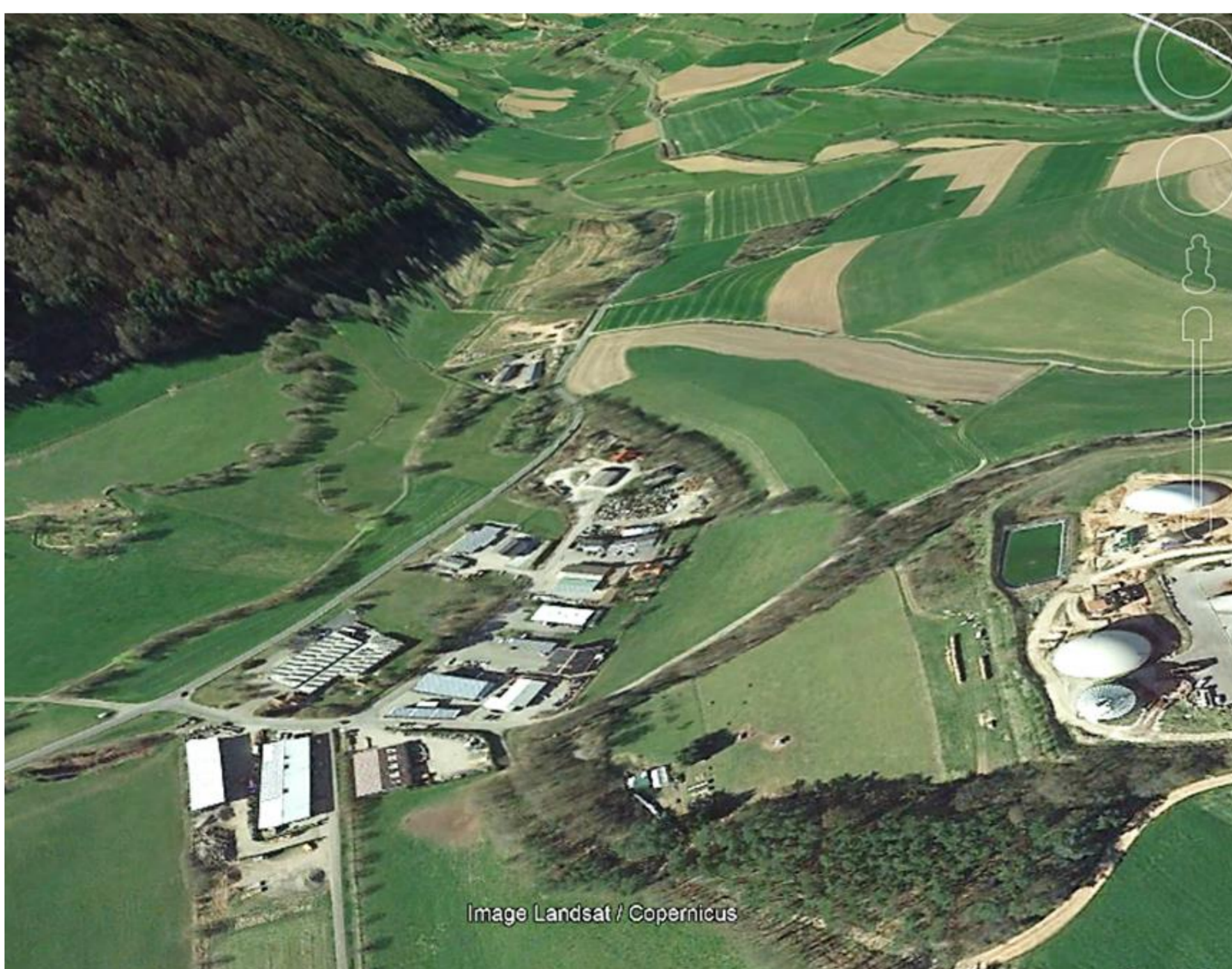
2021 Luftbild Gewerbegebiet Burgjoß Aspentalchen.
