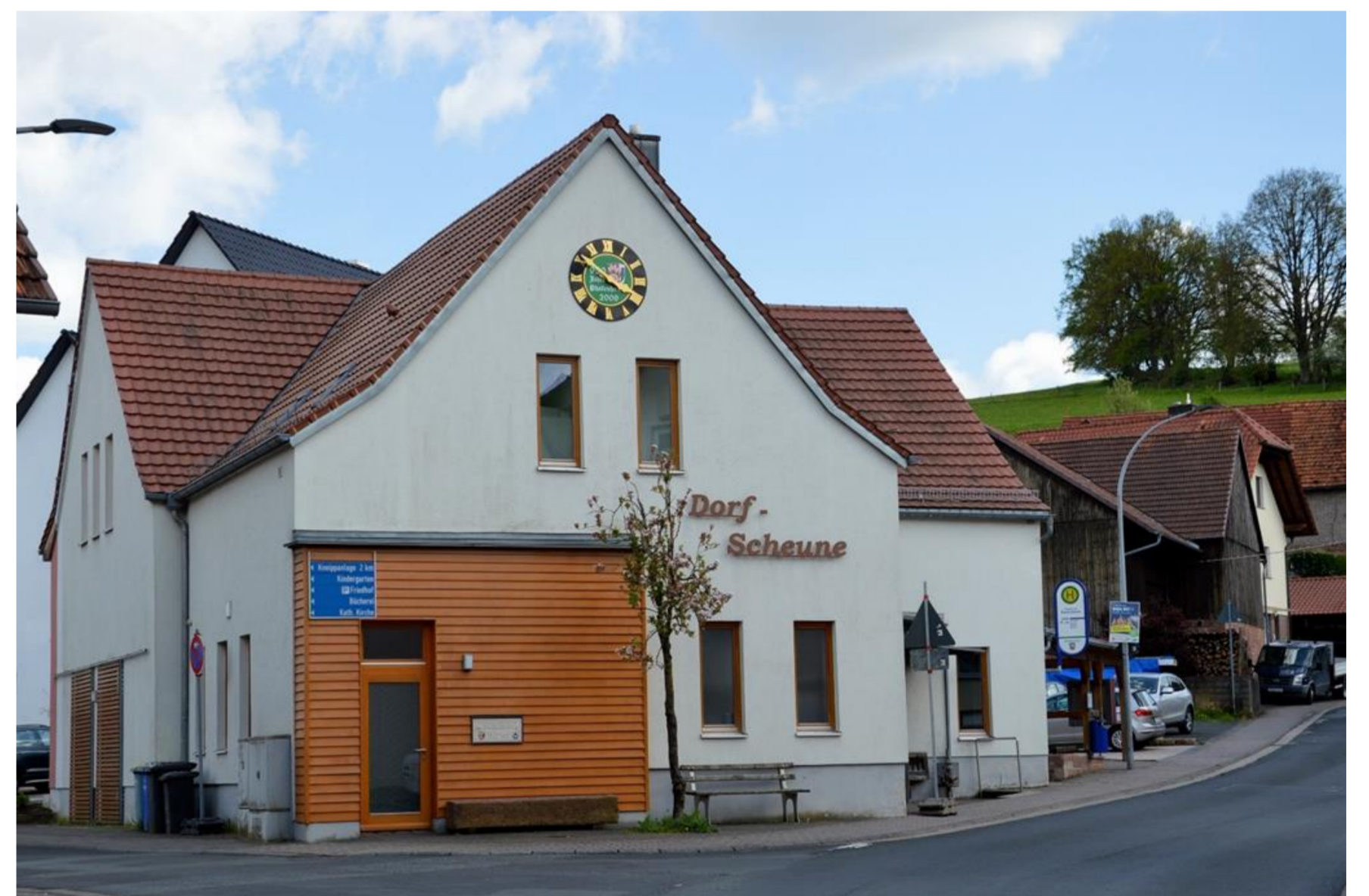
2002 Durch bürgerschaftliches Engagement wird in Pfaffenhausen bei der Dorferneuerung das ehemalige Raiffeisengebäude zur "Dorfscheune" umgestaltet. Auch dieses DGH ist gedacht für verschiedenste Veranstaltungen (Gemeinschaftspflege, Förderung des kulturellen Lebens, Erwachsenenbildung, Heimat- und Jugendpflege, soziale Betreuung von Bürgern, Familienfeiern, Parteien und Kirchen) sowie als Wahllokal. ( Birgit Sinsel )
