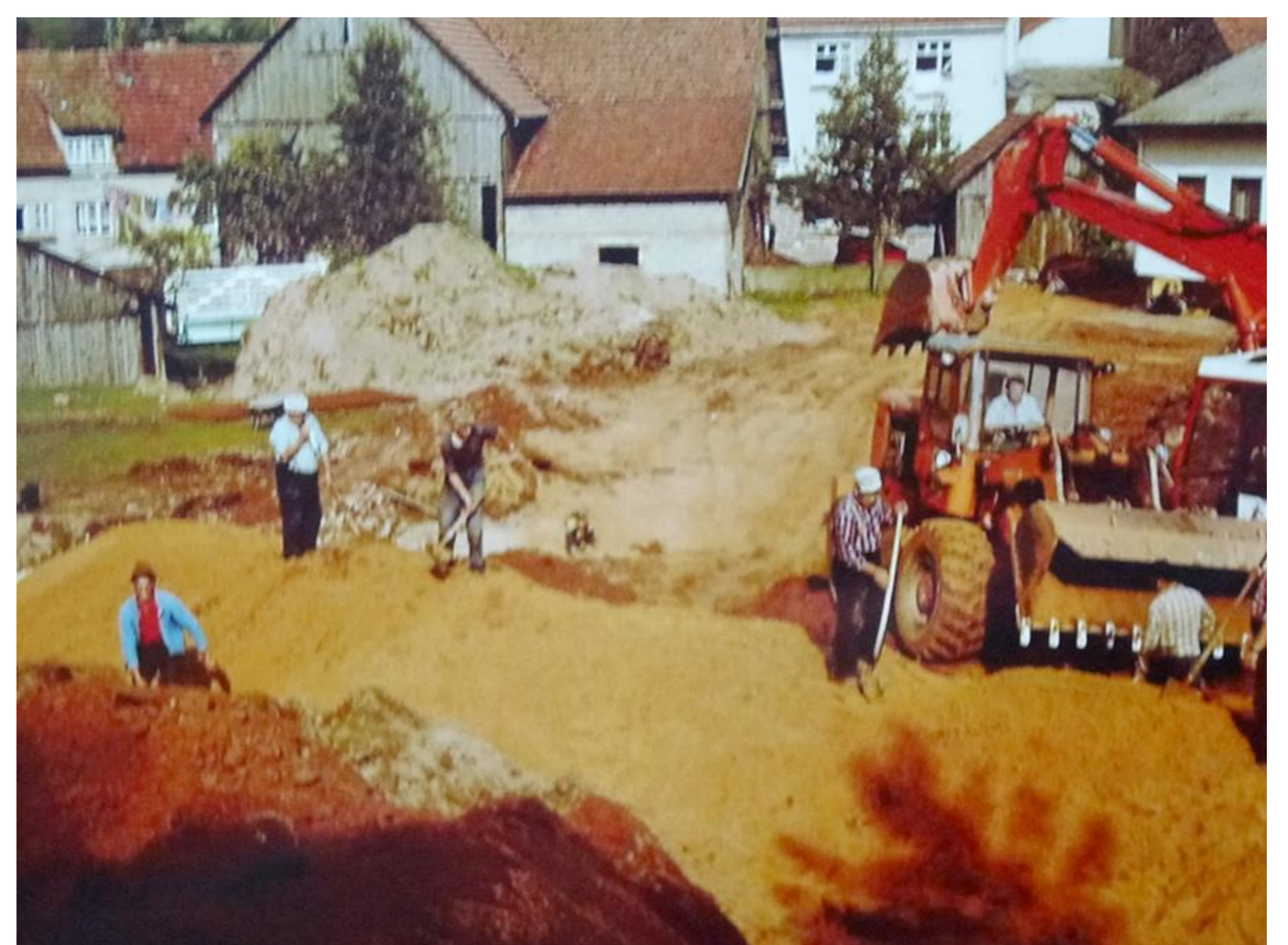
Bau der wichtigen Verbindungstraße in Oberndorf zwischen der Lohrer Straße und der Rabenbergstraße, genannt „Ferdlsturz“. ( Franz Korn )
