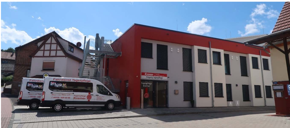
Abb. 19: Teil des Strategischen Sanierungsbereichs: Alten- und Pflegeeinrichtung „Haus Spessart“
