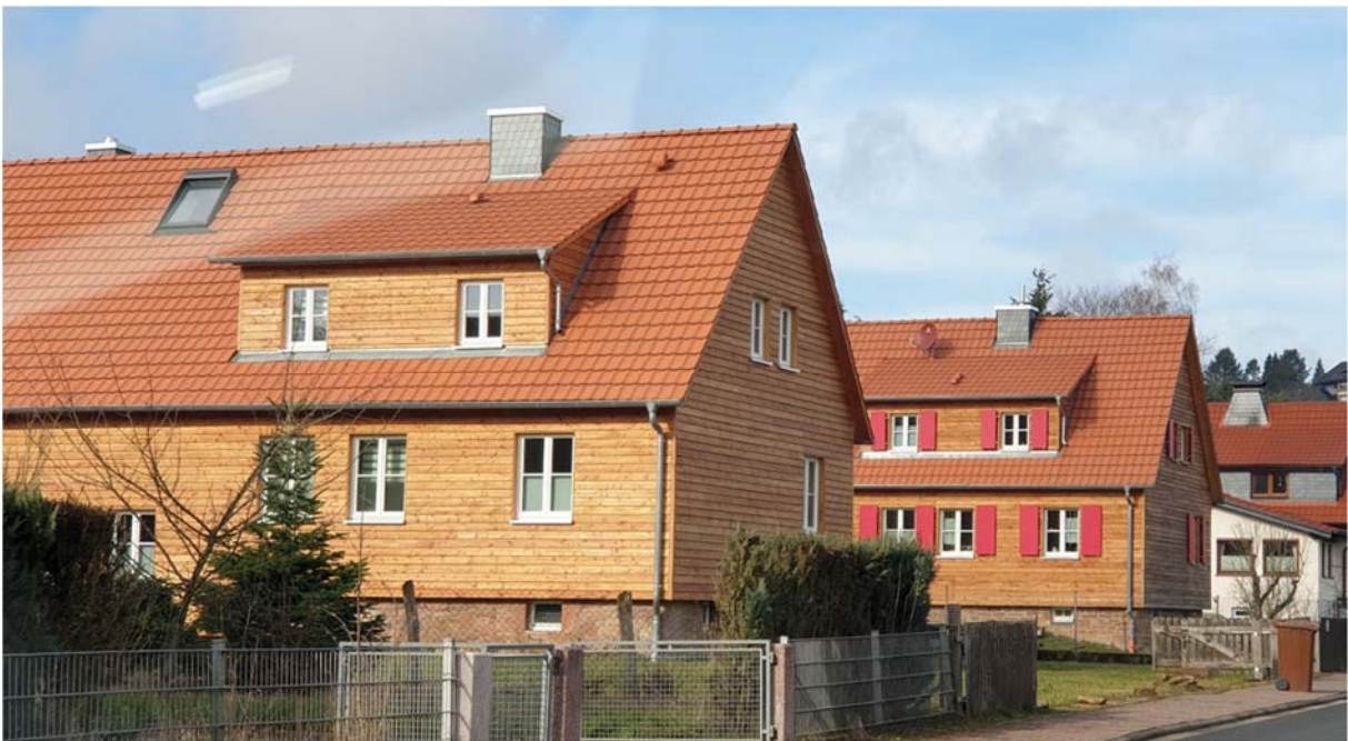
Abb. 16: Sanierte Streckhöfen (Lettgenbrunn) Quelle: Gemeinde Jossgrund, 2023
